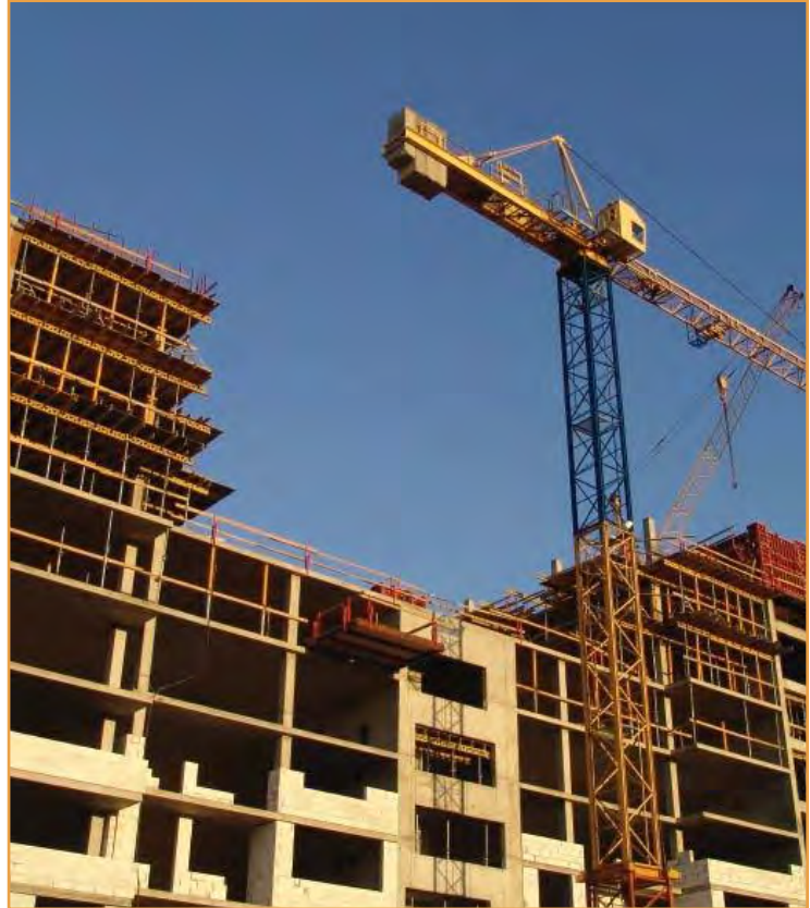
Edificios de viviendas en construcción
