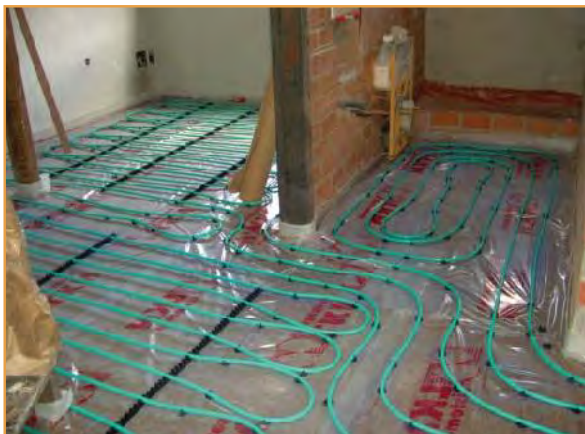
Instalación de suelo radiante
