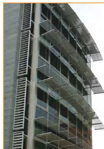
Edificio bioclimático Trasluz
