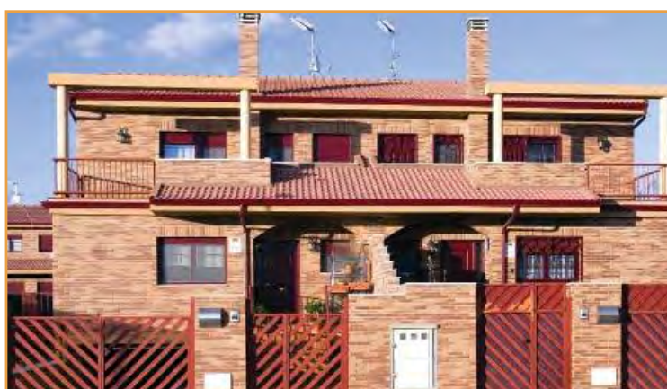
Adosados de nueva construcción.
