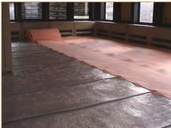
Aislamiento en suelo con polietileno reticulado
